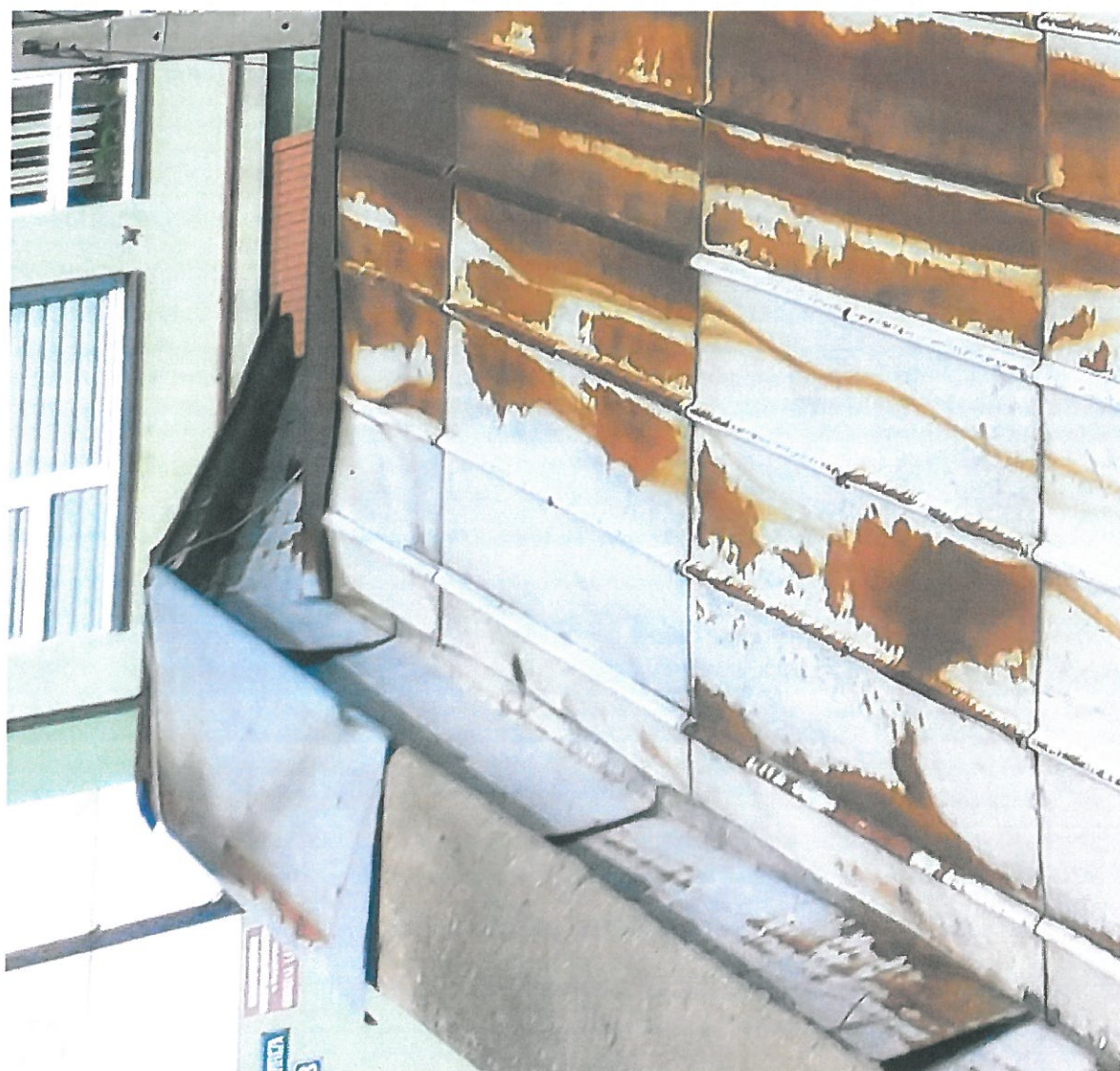
Rys – 4 OBRÓBKA FIREMURU + GĄSIORY KALENICOWE
