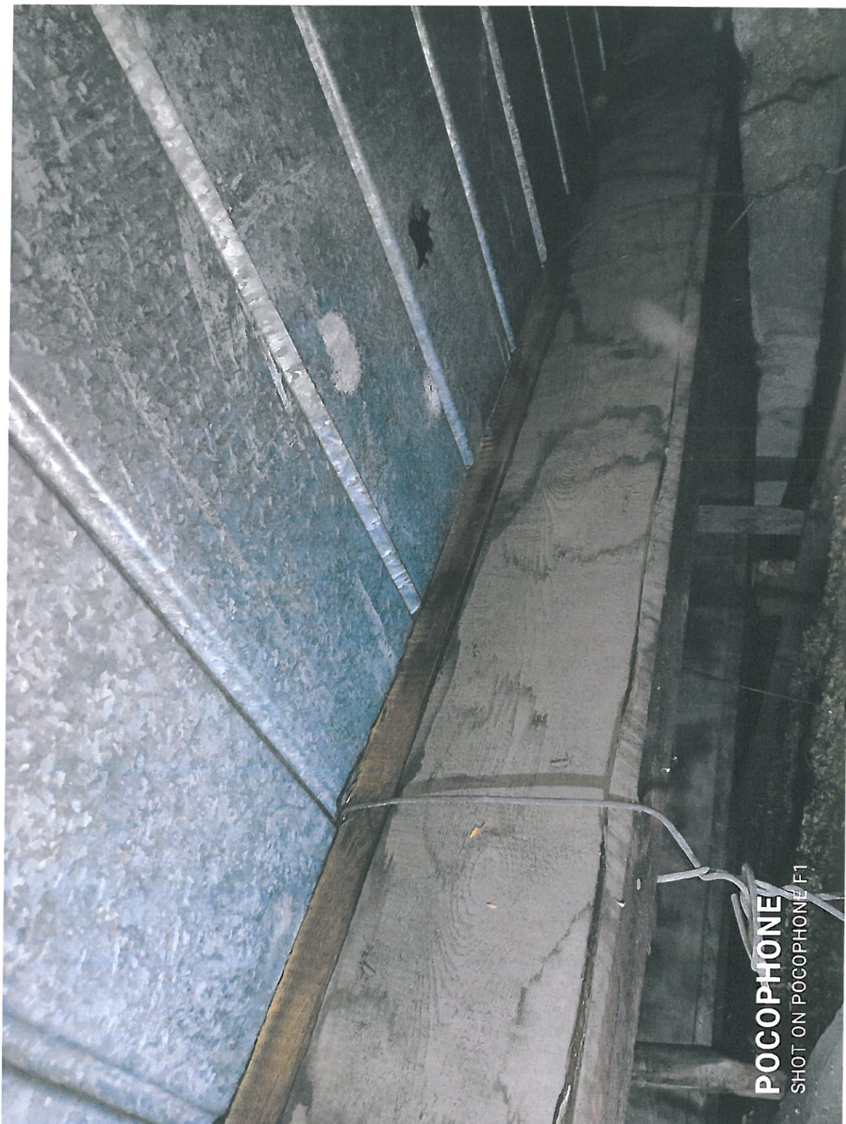
Rys – 9 Wgląd przez otwór w suficie do przestrzeni stropodachu
